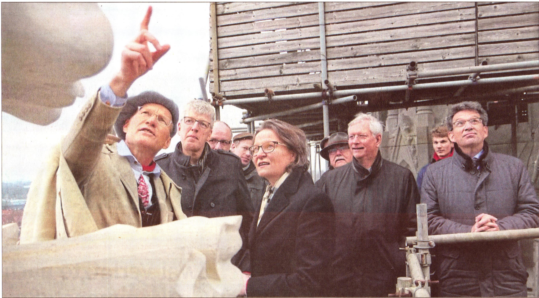
Dombaumeister Jürgen Prigl (links) erläuterte Städtebauministerin Ina Scharrenbach die Sanierungsarbeiten an den Türmen der Wiesenkirche. Das Gespräch verfolgen (von links) Wiesepfarrer Kai Hegemann, Detlef Schönberger, Hauptgeschäftsführer der Kreishandwerkerschaft Hellweg-Lippe, Steinmetzmeister Daniel Müller, Heinz Piel, Vorsitzender des Westfälischen Dombauvereins, Eckhard Uhlenberg, Präsident der NRW-Stiftung, und Bürgermeister Dr. Eckhard Ruthemeyer. ■ Foto: Fischer
